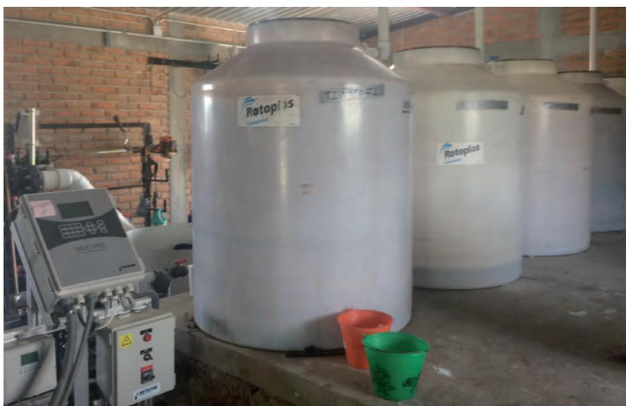
Figura 2.2. Componentes de un sistema de fertirrigación: Estanques, inyector de fertilizantes y agitador.
